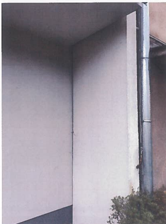
Widoczne dwie, niezależne warstwy ocieplenia
