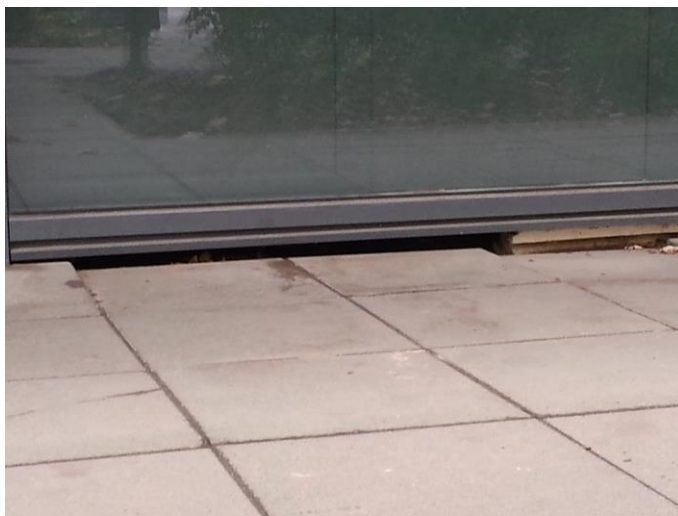
Zdjęcie nr 11. Remont chodnika- strona „Konsmetal”
