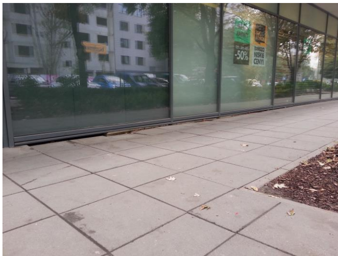
Zdjęcie nr 8. Remont chodnika- „Biedronka”
