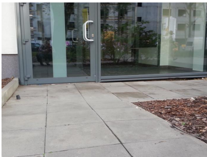
Zdjęcie nr 4. Remont chodnika- klatka nr 1
