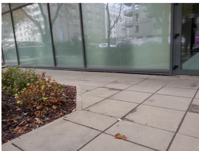
Zdjęcie nr 6. Remont chodnika- klatka nr 2
