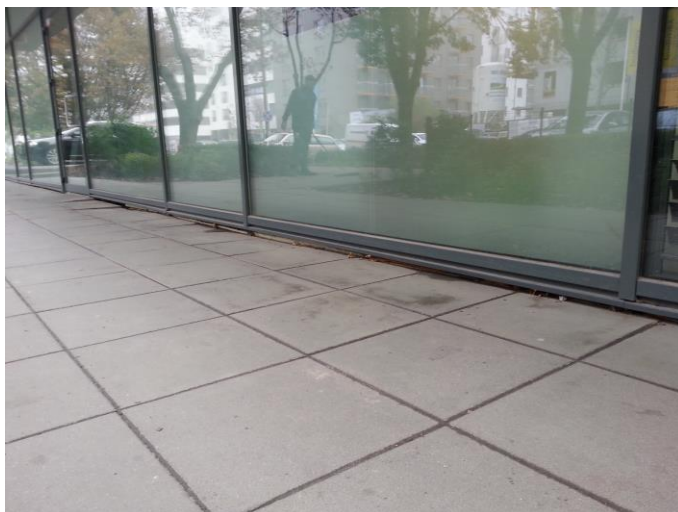
Zdjęcie nr 12. Remont chodnika- strona „Konsmetal”
