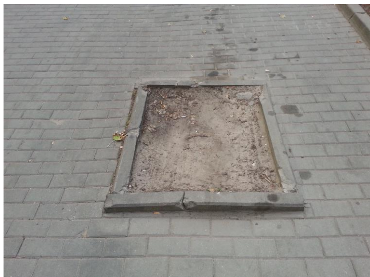
Zdjęcie nr 3. Miejsce wykonania kostki brukowej
