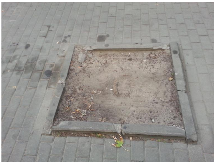
Zdjęcie nr 1. Miejsce wykonania kostki brukowej
