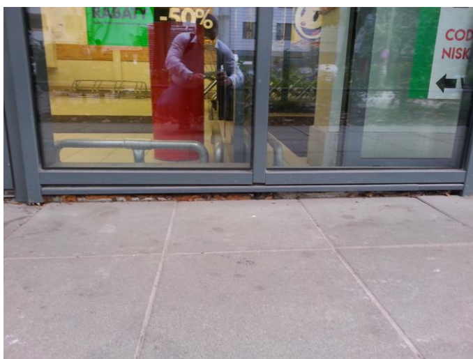
Zdjęcie nr 9. Remont chodnika- „Biedronka”
