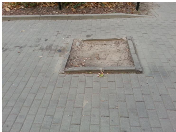
Zdjęcie nr 2. Miejsce wykonania kostki brukowej
