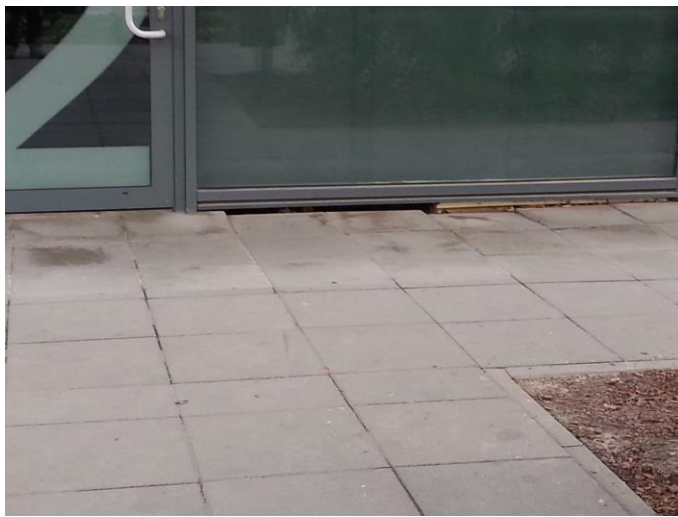
Zdjęcie nr 7. Remont chodnika- klatka nr 2
