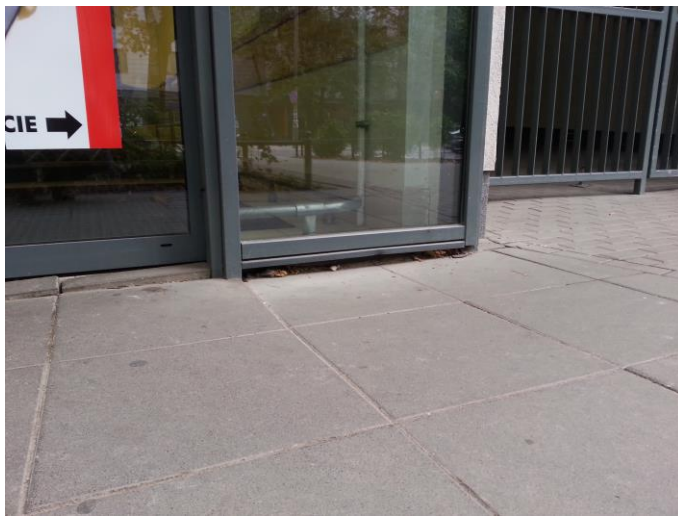
Zdjęcie nr 10. Remont chodnika- „Biedronka”
