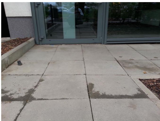
Zdjęcie nr 5. Remont chodnika- klatka nr 1
