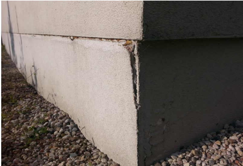
Zdjęcie nr 2. Poglądowy stan elewacji.
