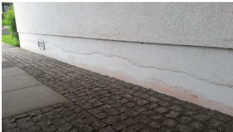
Zdjęcie nr 1. Poglądowy stan elewacji.
