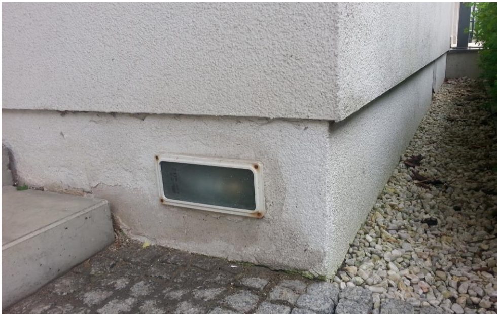
Zdjęcie nr 3. Poglądowy stan elewacji.
