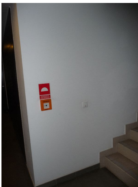
Zdjęcia poglądowe: poziom 0 (parter, klatka nr 11)
