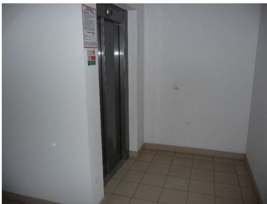
Zdjęcia poglądowe: poziom -2 (klatka nr 11)
