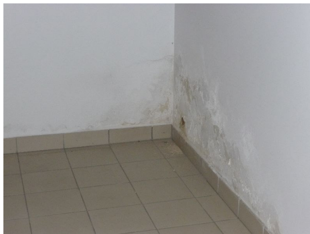
Zdjęcia poglądowe: poziom -2 (garaż, klatka nr 2)
