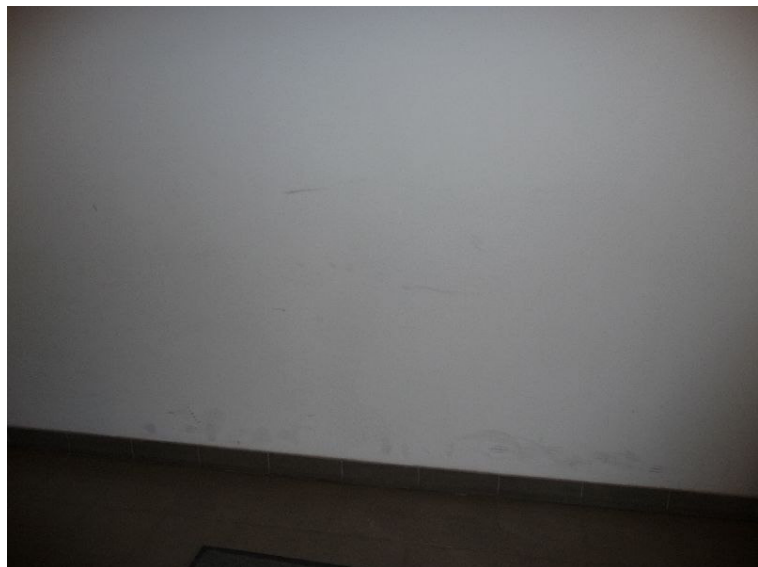
Zdjęcia poglądowe: poziom 0 (parter, klatka nr 7)
