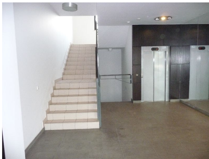
Zdjęcia poglądowe: poziom 0 (parter, klatka nr 1)
