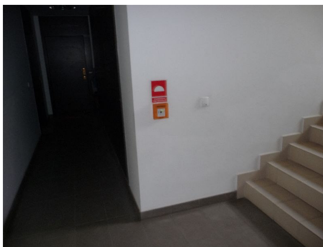
Zdjęcia poglądowe: poziom 0 (parter, klatka nr 10)
